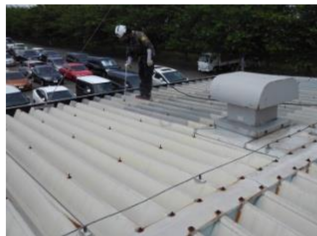
ヤマハ(株) 天竜工場 様 危険物倉庫屋根
