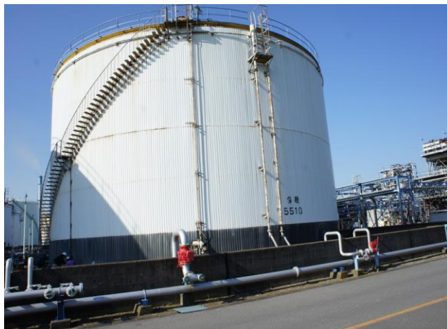
出光興産(株)千葉製油所 様 #5510タンク
