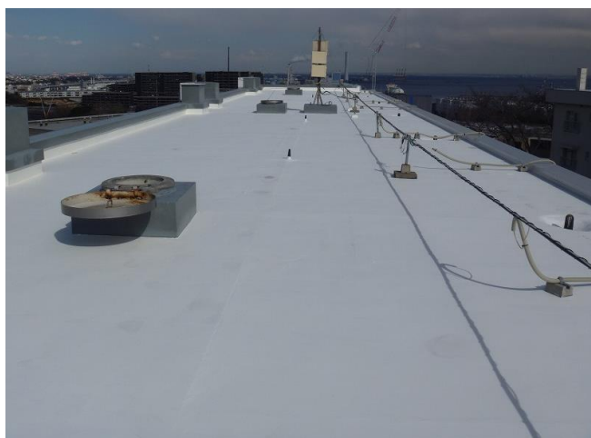
(株)IHI社 第5磯子荘 様 屋上アスファルト
