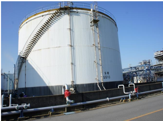
出光興産(株)千葉製油所 様 #5510タンク
